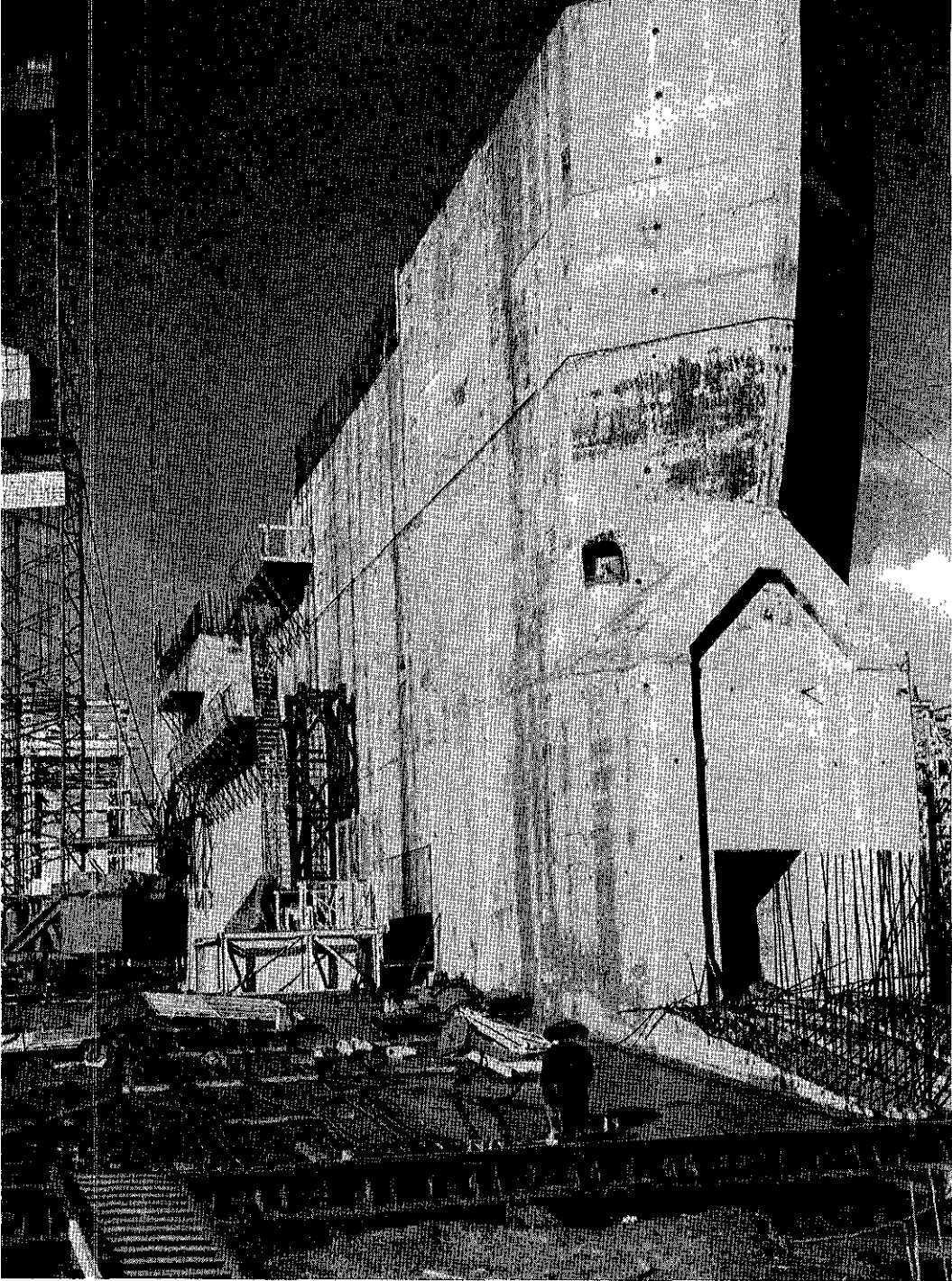
Een van de pijlers van de uitwateringssluizen in het Haringvliet, gereed tot N.A.P. + 10,50 m
