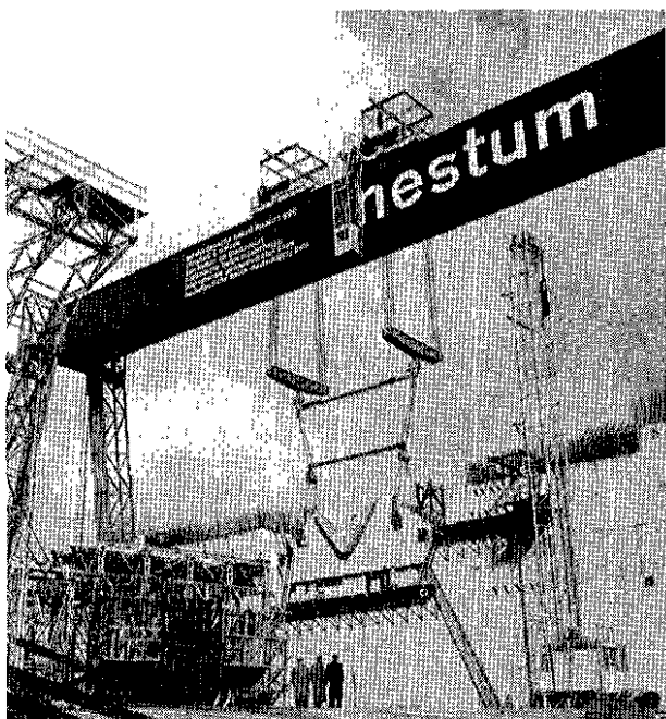
Het plaatsen van een eind- schotgedeelte van de Nablaligger
