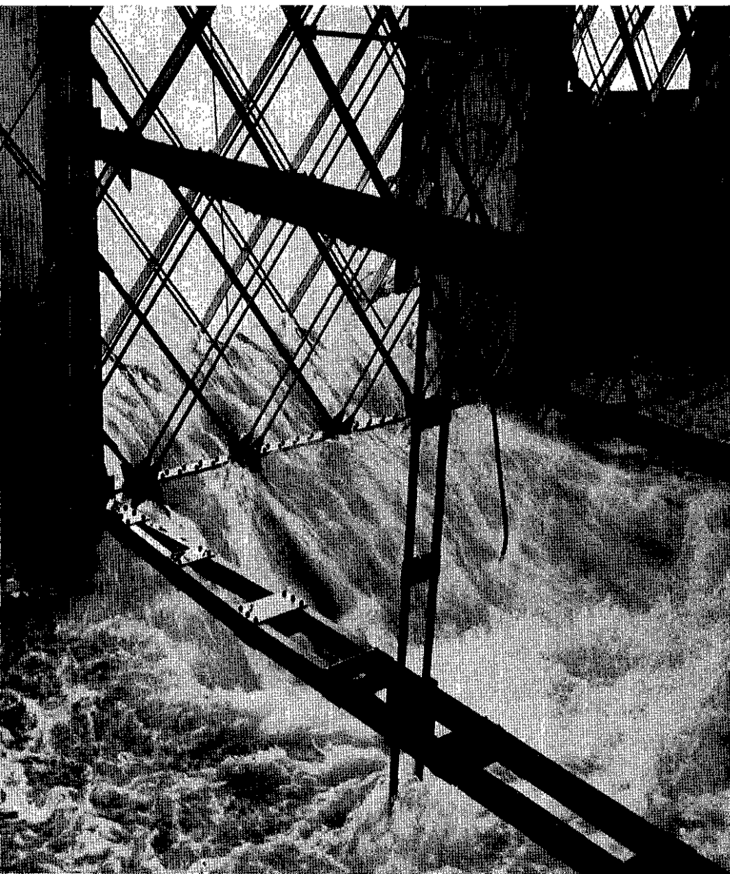
Met grote snelheid stort de ebstroom zich over de gesloten onderschuiven in de caisson (27 april, omstreeks 7 uur 's ochtends)
